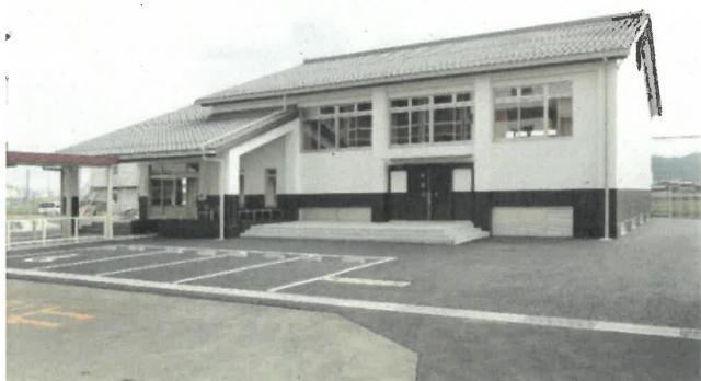
野洲北中学校 柔剣道場 平成26年3月 新築
