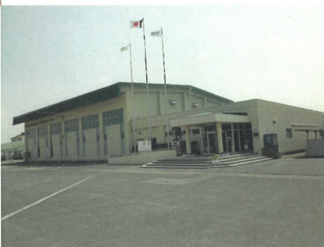
中主B&G海洋センター 平成30年3月 大規模改修
