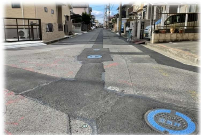
配水管更新工事の舗装
