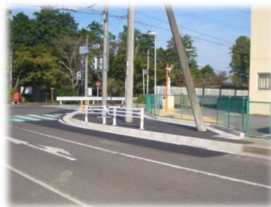
通学路の歩道拡幅・安全対策
