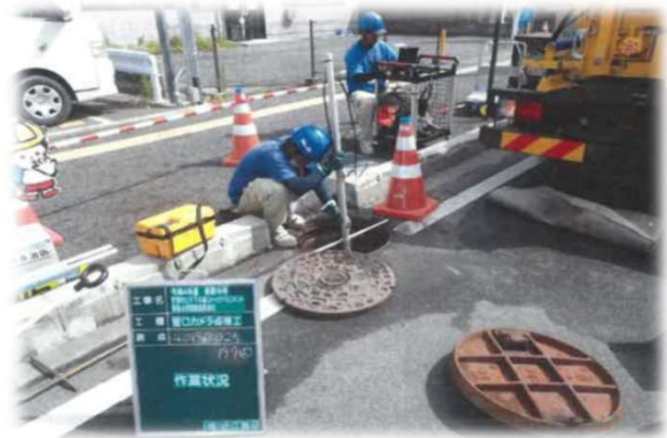
下水道施設の点検
