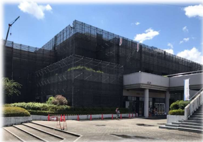
改修中の野洲市総合体育館
