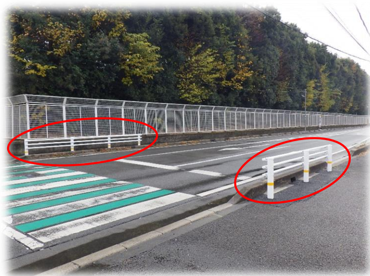
市内交差点部の防護柵設置
