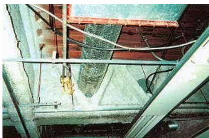
S 造の梁・柱・EVS・PS の耐火被覆
