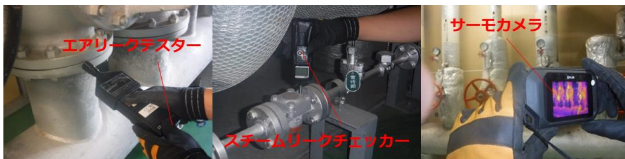
図. (左) エア漏れ、(中) 蒸気漏れ、(右) 断熱状態をチェックする調査ツール
