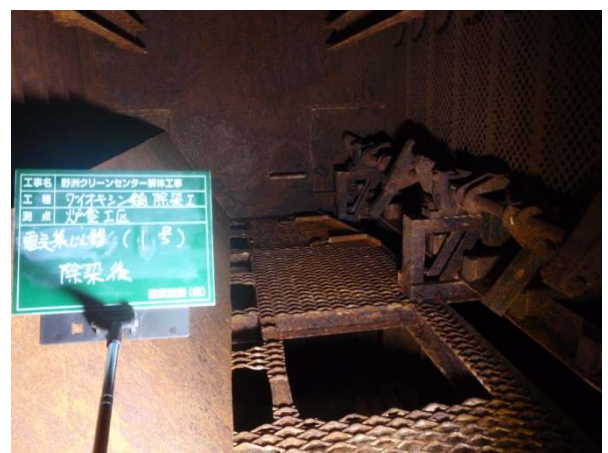
設備内除染後の状態
