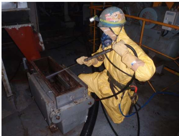
設備内除染の状態
