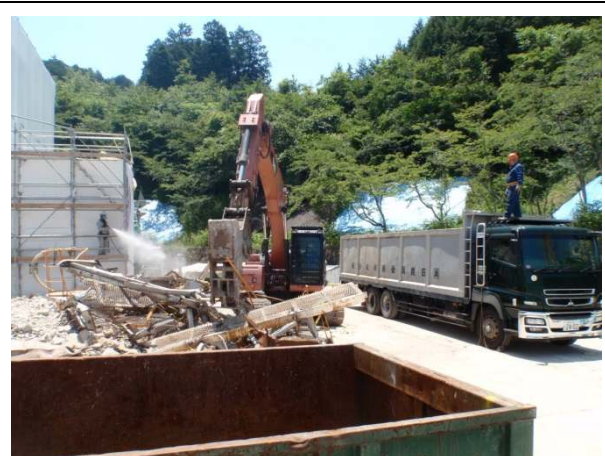
屋内設備（金属片）の搬出状態
