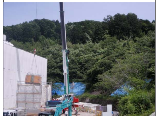
煙突解体の様子
