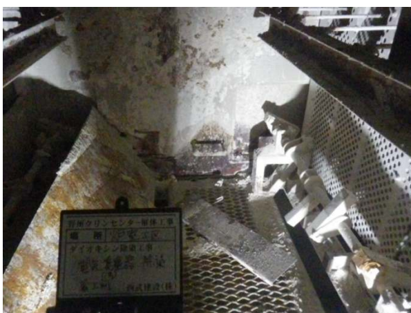
設備内除染前の状態
