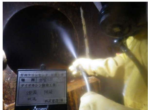
設備内除染の状態
