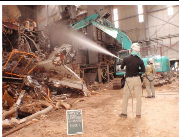
屋内設備の解体状態
