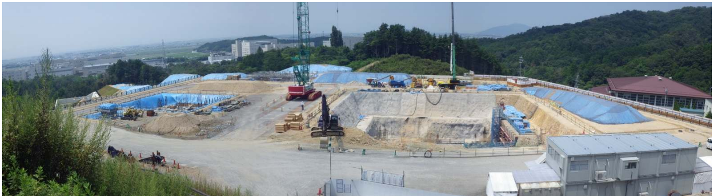
新野洲クリーンセンター建設工事現場の状況(平成 27 年 7 月 31 日撮影)
