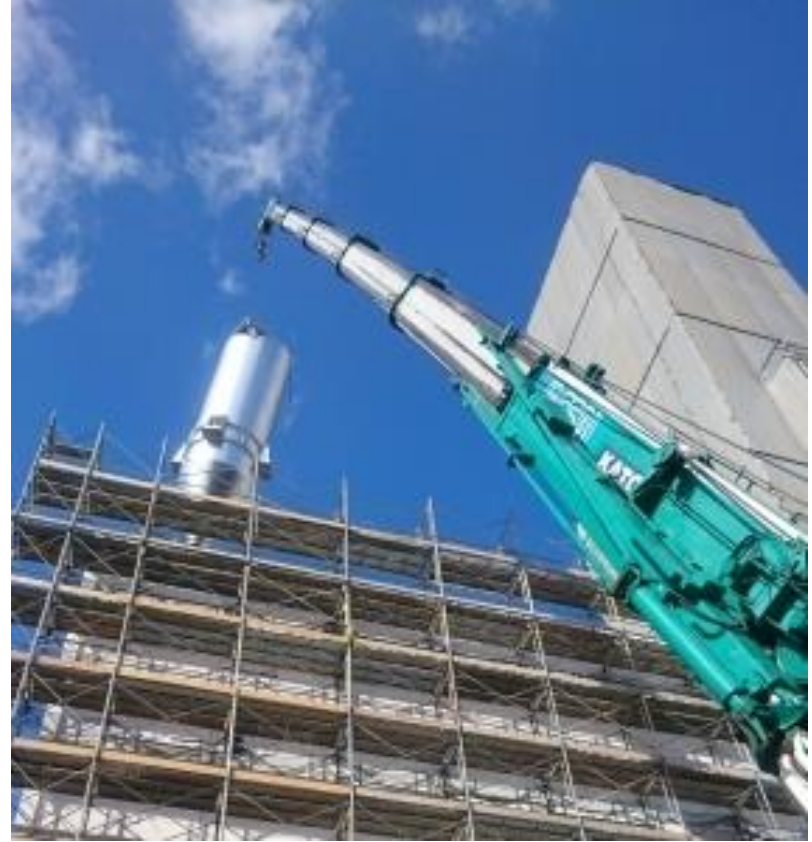
消石灰サイロをクレーンで取り込んでいるところです。
