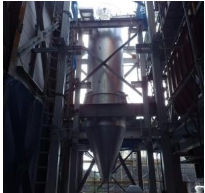
天井から取り込んだサイロも炉室内に据付けられました。
