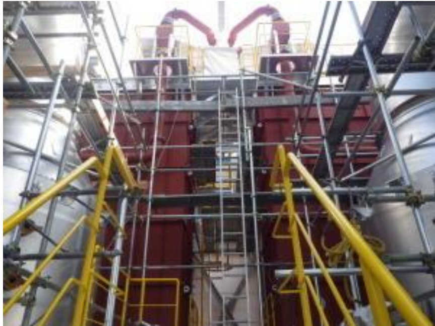
手前の銀色の機器がガス冷却室、奥の赤褐色の機器が空気予熱器です。
