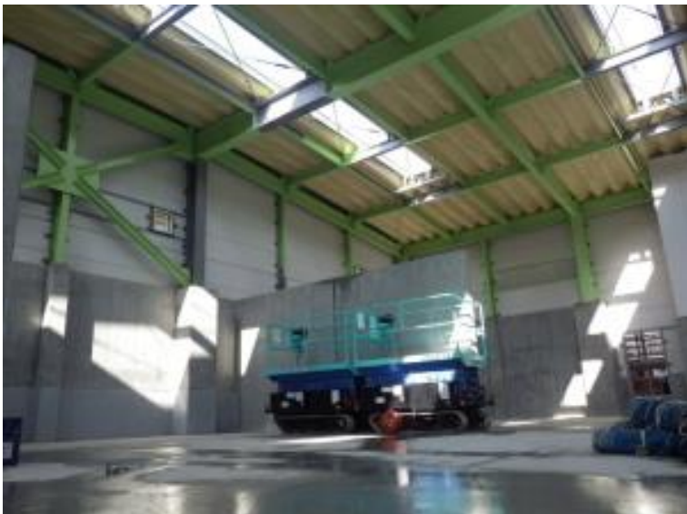
リサイクルセンターのプラットホームは、壁板設置及び屋根葺き並びに鉄骨の塗装が完了しました。
