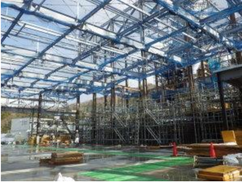
熱回収施設のプラットフォームは床のコンクリート打設が完了しました。
