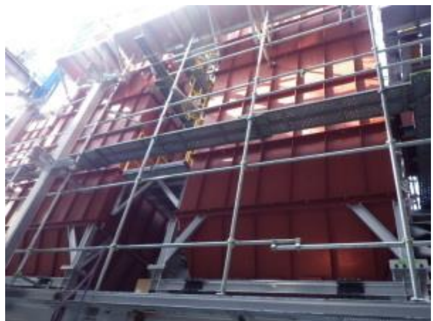
排ガス中のばいじんを捕集するバグフィルタが据え付けられました。
