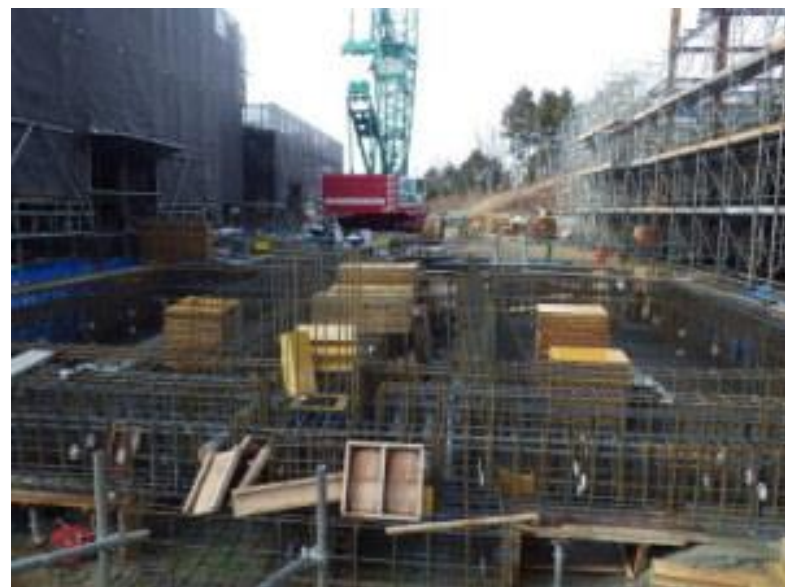
リサイクルセンターと熱回収施設の間に計量棟と渡り廊下を設けます。現在は基礎コンクリートの配筋を施工しています。
