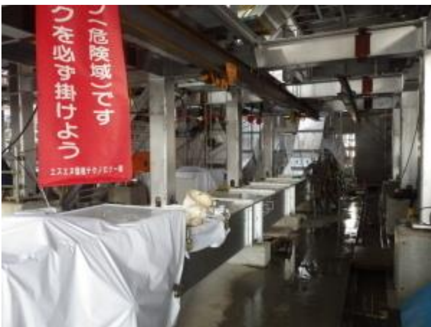
焼却炉で発生した焼却灰を灰ピットまで搬送するコンベヤが1階に据え付けられました。
