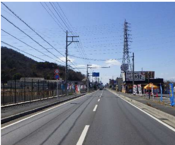
▲写真 国道8号（都市計画道路出庭大篠原線）
