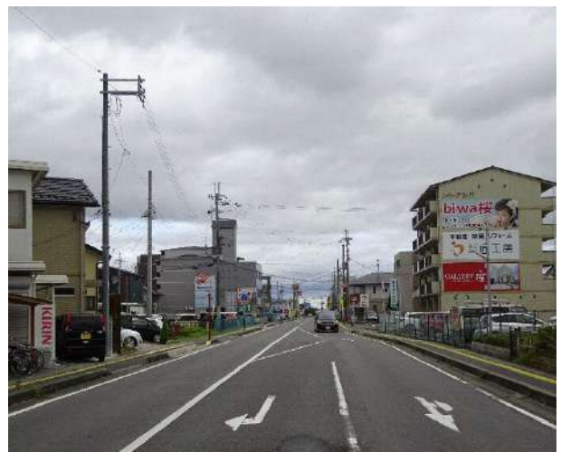
▲写真 主要地方道大津能登川長浜線沿道
