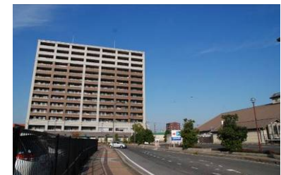
野洲駅西側の高層マンション
