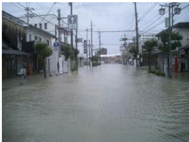
平成25年台風18号豪雨による妓王井川(野洲駅前)の溢水状況
