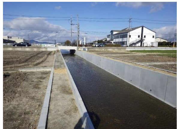
友川改修（童子川第4排水区雨水幹線整備事業）
