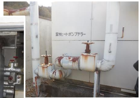
【空調設備 屋外】
