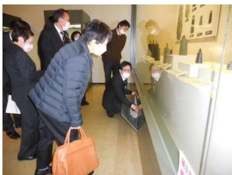
【第 1 展示室空調機器】
