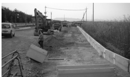
市内の公共工事
