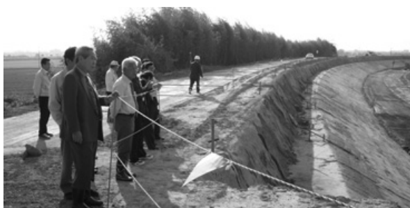
現地視察(日野川改修工事)
