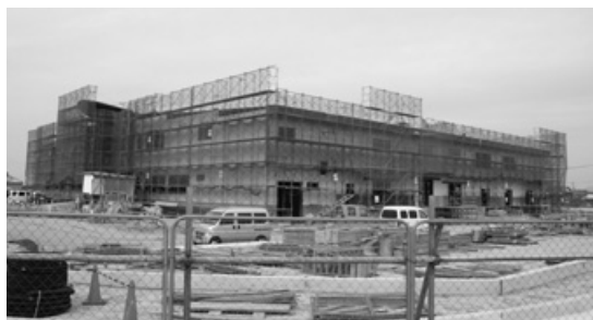
工事の進む学校給食センター(八夫地先)
