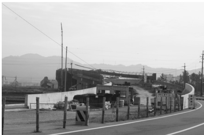
県道野洲中主線高架橋工事(上屋地先)
