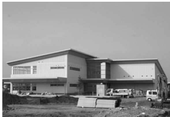
コミュニティーセンターひょうず建設工事(六条地先)
