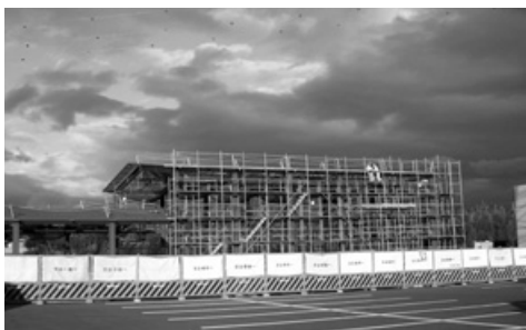
建設中のなかよし交流館
