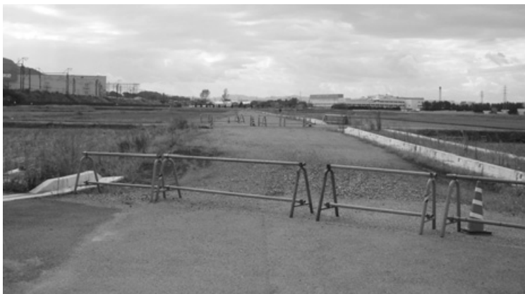
平成20年供用開始予定の農道
