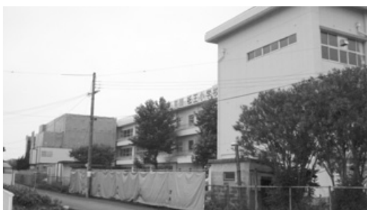
改修の進む祇王小学校
