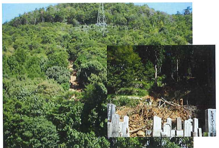
妙光寺土砂崩れ
