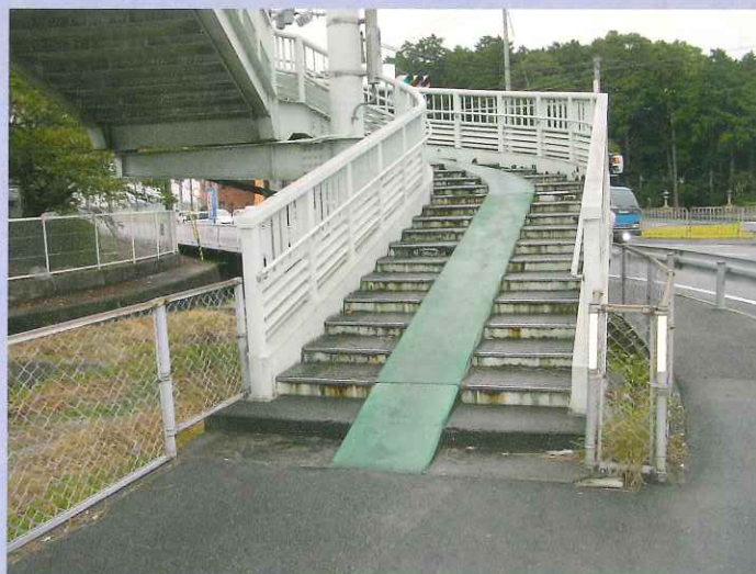
現地歩道橋写真
