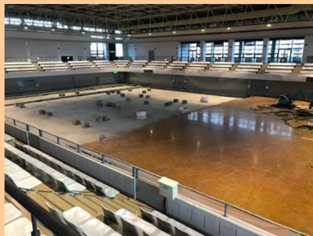
▲古い体育館の床を取り除く様子
