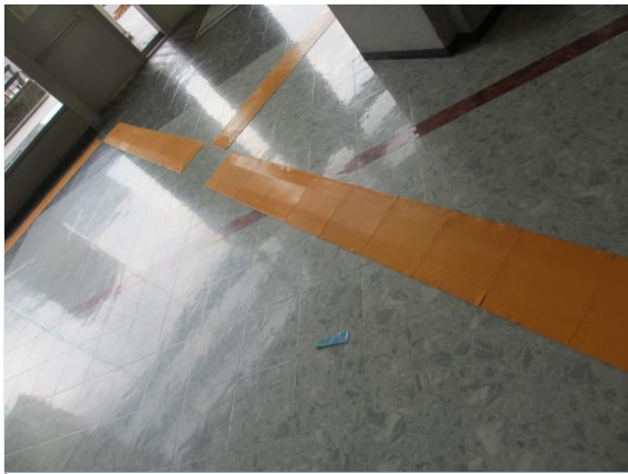
仮設点字ブロック
