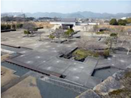
図 6.7 木材+床版による御殿間取り表示 (赤穂城本丸御殿)
