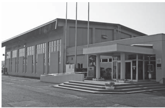
中主B & G海洋センター体育館
