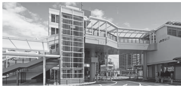
野洲駅北口駅前広場
