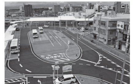
野洲駅南口駅前広場
