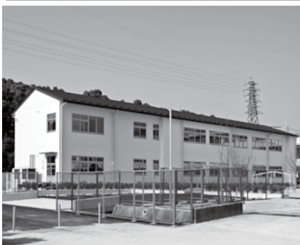
北野小学校増築校舎棟
