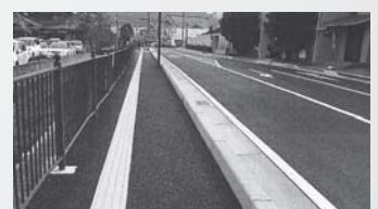
バリアフリー化された歩道
