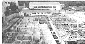
野洲中学校改築現場
