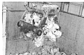
野洲クリーンセンター
