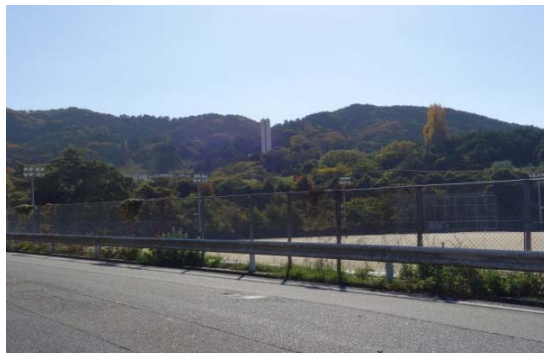
現況（平成 28 年度 施設稼働時）
