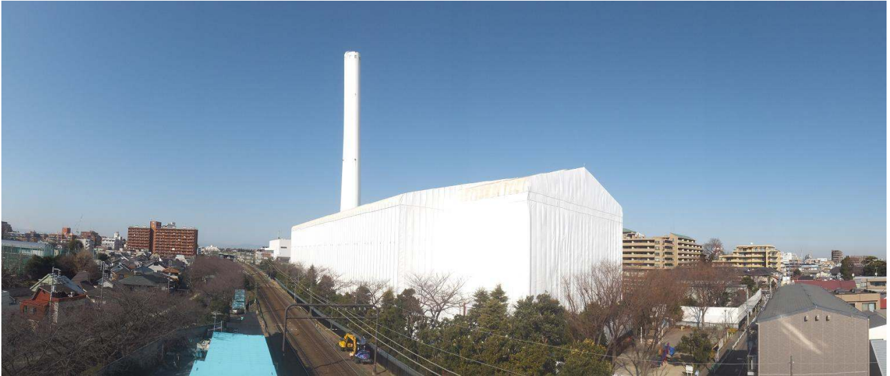
参考例：杉並清掃工場建替工事の外観（出典：東京都二十三区清掃一部事務組合ホームページより）
