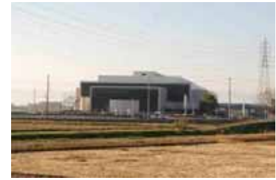
野洲市総合体育館
