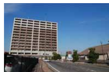
野洲駅西側の高層マンション
