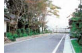
沿道修景整備
