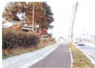
沿道修景整備
