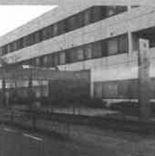
老朽化が進む野洲病院
